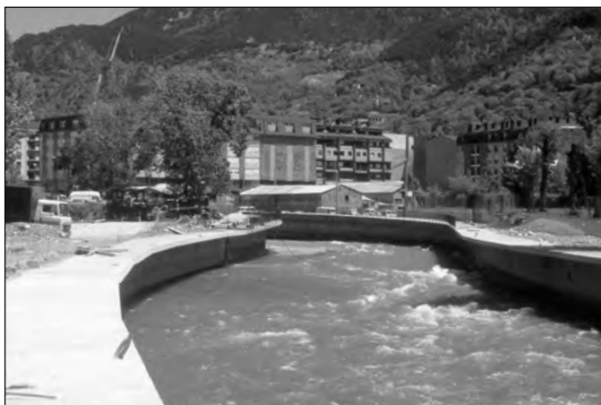
FIGURA 2. Canalització de la Valira a Andorra la Vella.
